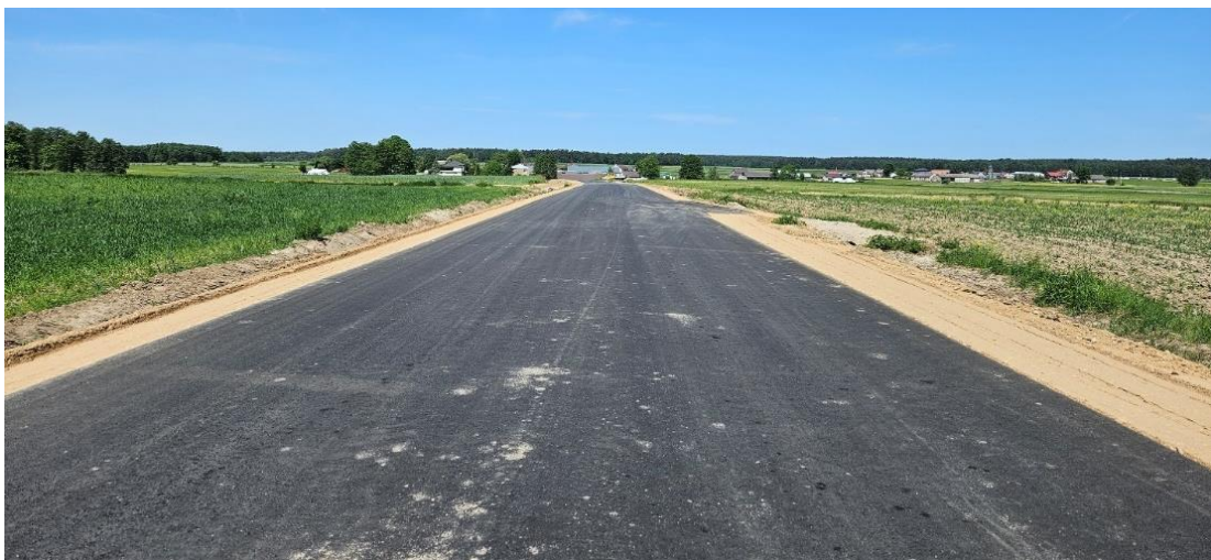
Fot. Droga po przebudowie na odcinku Gołębie – Kamińskie Wiktory.
