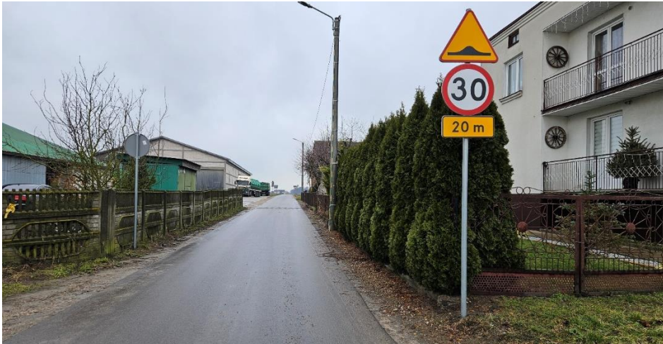
Fot. Zamontowany próg zwalniający w miejscowości Poświętne.
