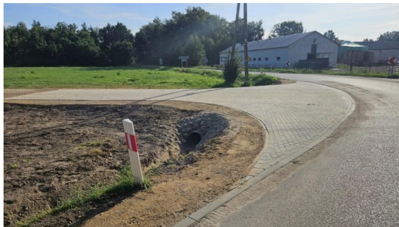
Fot. Przebudowany zjazd z drogi powiatowej nr 1566B w miejscowości Brzozowo - Korabie.
