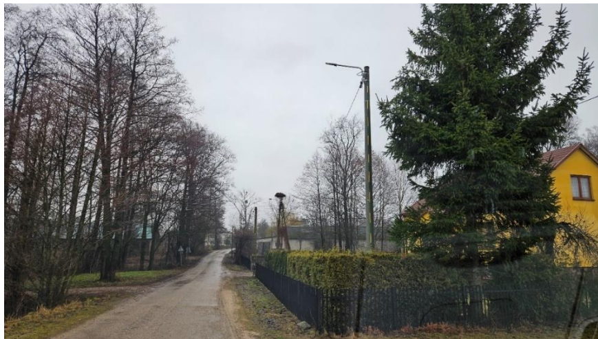
Fot. Oświetlenie uliczne w miejscowości Porosl – Gluchy.
