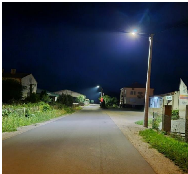
Fot. Oświetlenie uliczne w miejscowości Poświętne.
