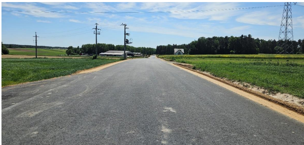
Fot. Droga po przebudowie na odcinku Gołbie – Kamińskie Wiktory.
