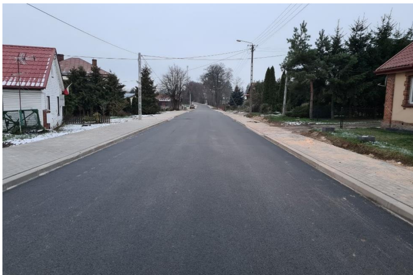
Fot. Droga powiatowa nr 1522B w miejscowości Pietkowo po przebudowie.
