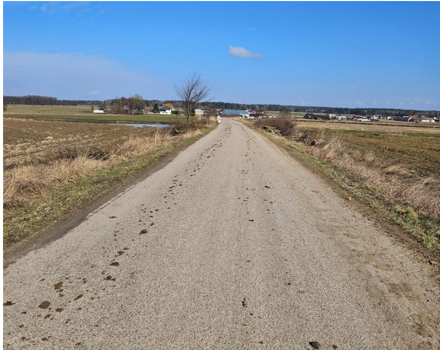
Fot. Droga przed przebudową na odcinku Gołębie - Kamińskie Wiktory.
