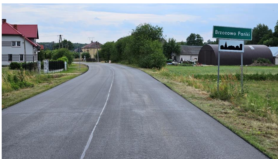
Fot. Droga powiatowa nr 1565B na odcinku Brzozow Stare – Brzozowo - Panki po przebudowie.
