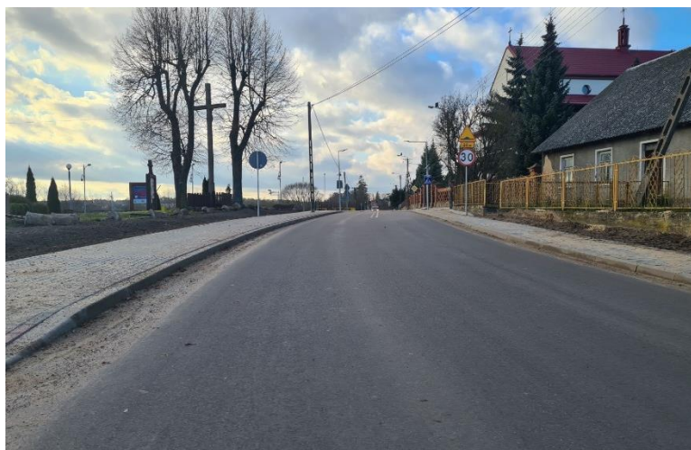
Fot. Droga powiatowa nr 1522B w miejscowości Pietkowo po przebudowie.
