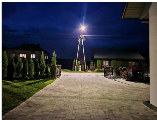
Fot. 5. Modernizacja oświetlenia ulicznego
