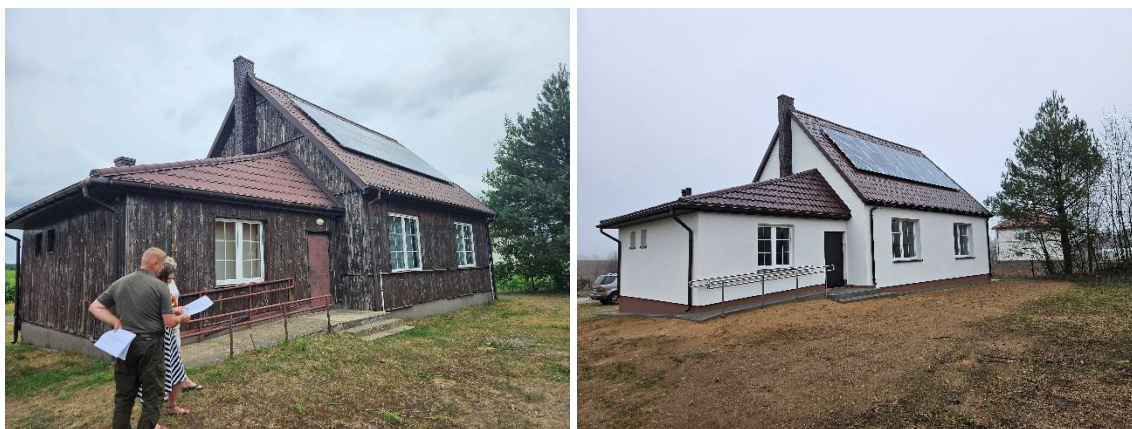
Fot. 1. Świetlica w Zdrodach Nowych przed i po modernizacji
