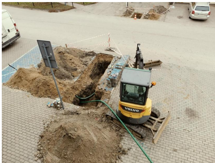
Fot. 4. Przebudowa istniejącej sieci kanalizacji ciśnieniowej w miejscowości Poświętne
