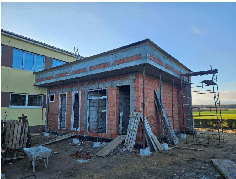
Zdjęcie 6. Stan surowy budynku "Bajkowego Żłobka" w Poświętnem
